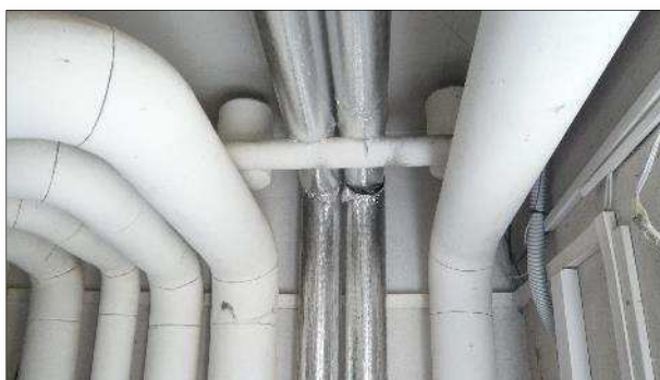
CZT přívodní potrubí
